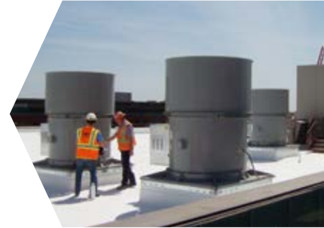
Fan Assembly Inspection
