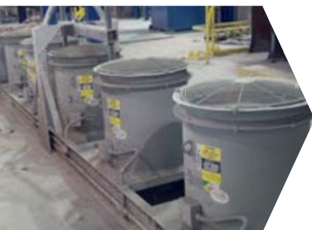
Steel Slag Cooling
